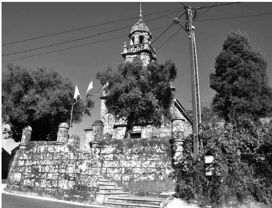
A noble fachada do templo parroquial de Guimarei, a escalinata e o antiestético poste da luz que cómpre retirar.
